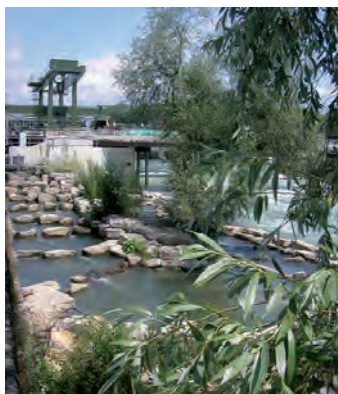
Fischtreppe beim Wasserkraftwerk Rheinfelden
