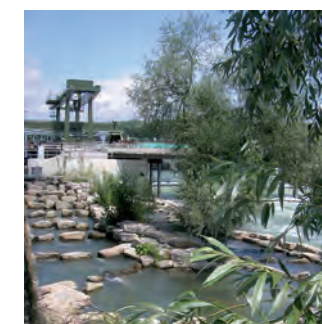
Fischtreppe beim Wasserkraftwerk Rheinfelden
